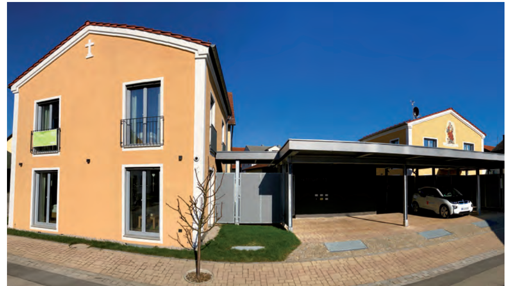
Das Landhaus Altmuehltal mit überdachten Parkplätzen und Ladestation für Elektroautos (© Landhaus Altmuehltal)
