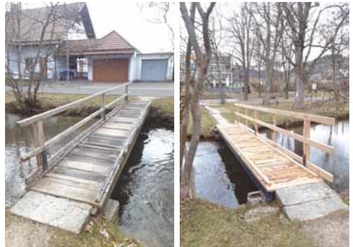
Nun hat der städtische Bauhof die Brücke abmontiert und erneuert. Die Stahlkonstruktion wurde gesäubert, neu gestrichen und wieder angebracht. Der Belag und das Geländer wurden aus Eichenholz, welches vom Stadtwald stammt, neu angefertigt und montiert.
