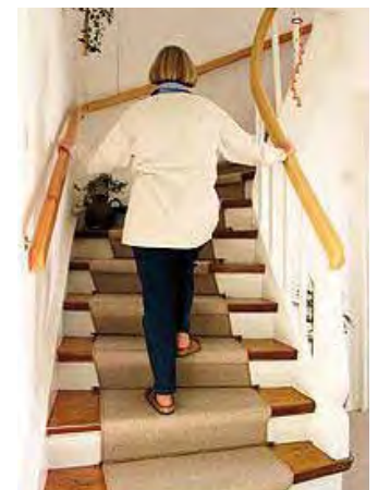
Treppe zweiter Handlauf
